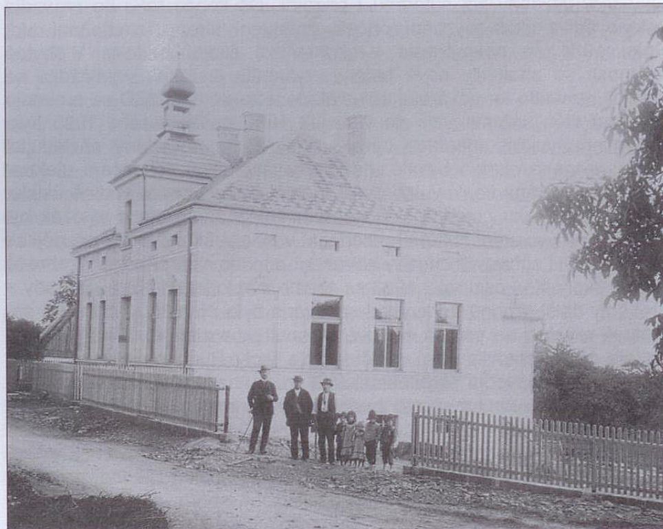
Novostavba školy v roce 1909.
